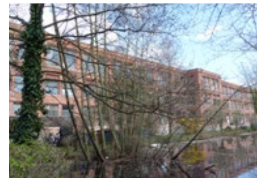
Bâtiment N° 75: ancien bâtiment de constructions mécaniques et autres activités diverses accueille aujourd'hui des ateliers d'artistes / Im ehemaligen Maschinenbaugebäude befinden sich heute v.a. Künstlerateliers.
