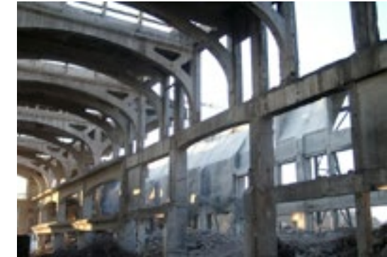
Teilabbruch Démolition Foto: Christian Plisson
