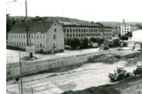
Verlegung des Gewerbekanals, 2000 Travaux de construction sur le nouveau quartier Innocel, 2000 Foto: Wolfgang Göckel
