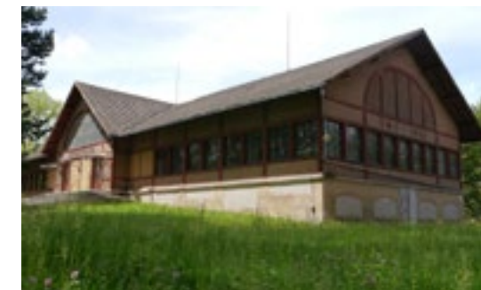
Die ehemalige Werkskantine Le réfectoire Foto: Ina Krauß
