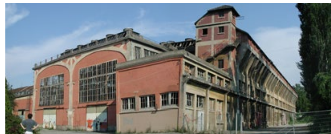
La Fonderie vor der Sanierung / La Fonderie avant la rehabilitation / Foto: Christian Plisson
