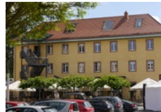
Kosthaus nach der Sanierung, beherbergt heute Unternehmen und Gastronomie / L'ancien réfectoire héberge aujourd'hui des entreprises et restaurants. Foto: Ina Krauß
