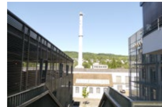
Blick vom Hochgestade auf die Produktionsflächen der KBC Vue de l'entreprise KBC Foto: Ina Krauß
