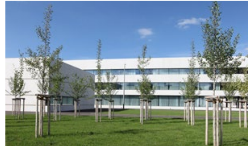
Roche Grenzach heute: geprägt von Neubauten, links neue Energiezentrale, hinten Gebäude für Verwaltung
