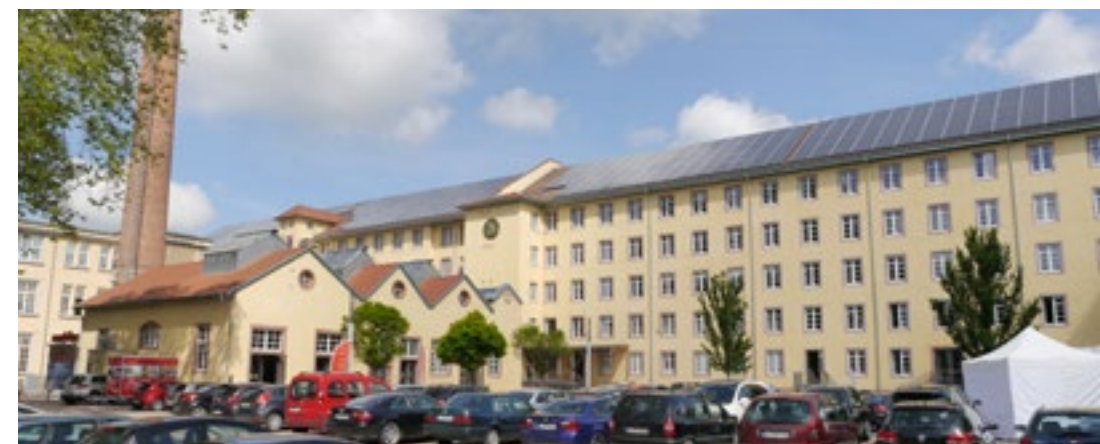
Bâtiments de l'ancienne filature et de la chaufferie, 2016 / Spinnerei-Hochbau und ehemaliges Kesselhaus, 2016 / Foto: Ina Krauß
