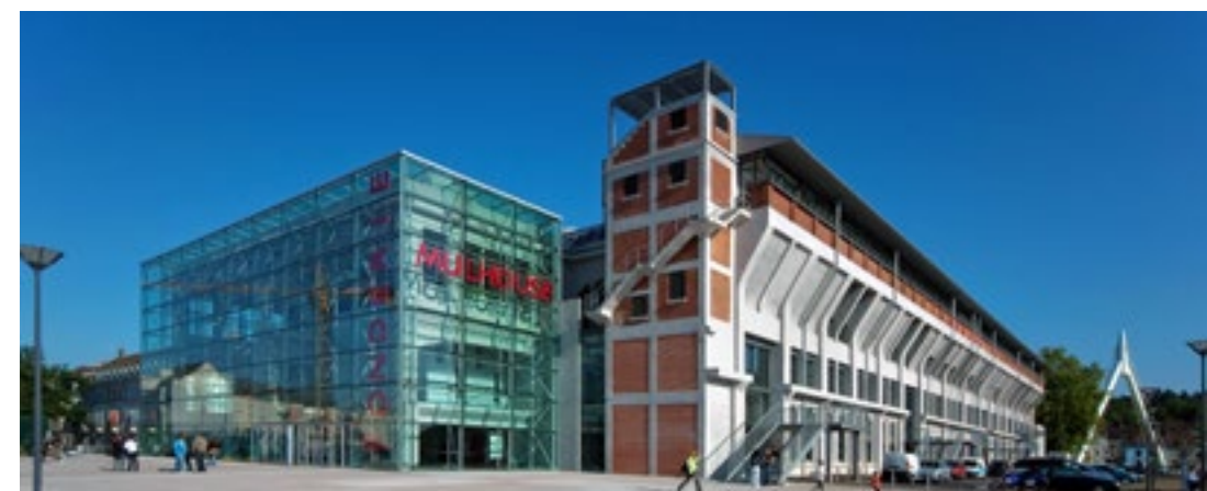
La Fonderie après la rehabilitation, 2007 / La Fonderie nach der Sanierung, 2007 / Foto: Christian Plisson
