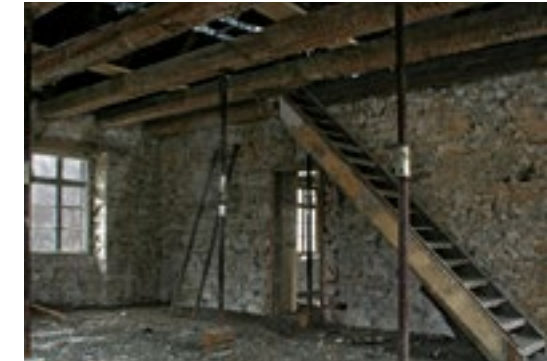
Im Inneren des Kosthauses, 2009 L'intérieur du réfectoire avant l'assainissement, 2009 Foto: Achim Schindler
